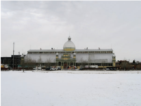
South elevation (ERA 2023)
