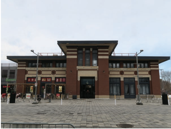
South Elevation (ERA 2023)
