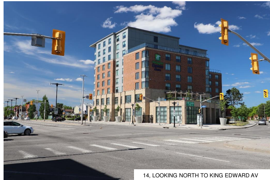
14, LOOKING NORTH TO KING EDWARD AV
