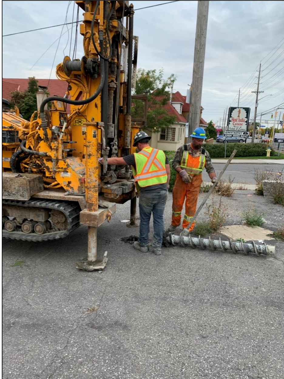
Réalisation du forage F-01
