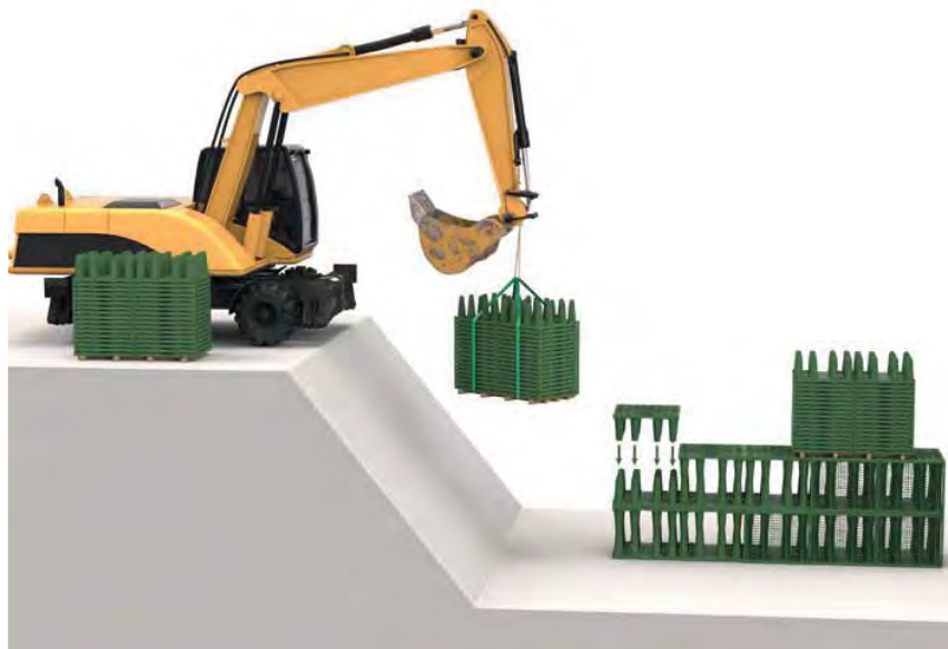
Montage dans la fouille
