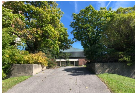
West Ramp (ERA, 2021)
